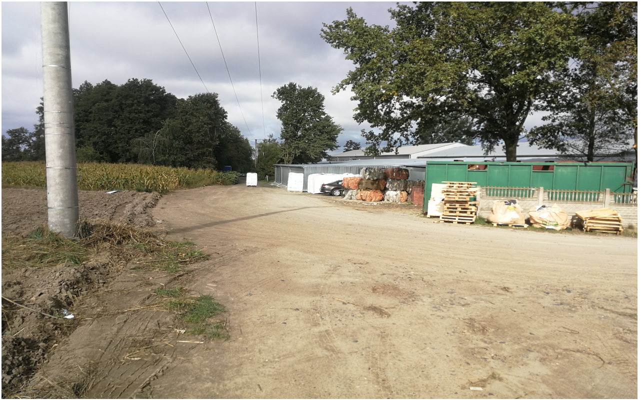
Fot. Nr 3 końcowy odcinek istniejącej drogi
