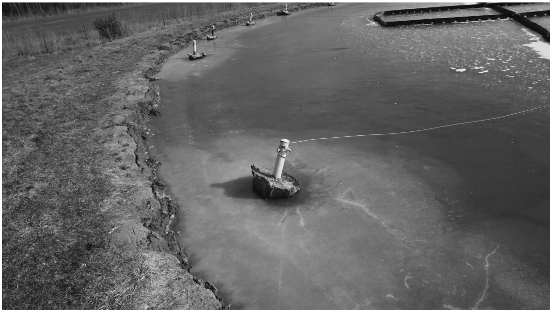
Widok uszkodzonych konstrukcji wsporczych dla odciągów linowych na rozmytych skarpach wewnętrznych stawu
